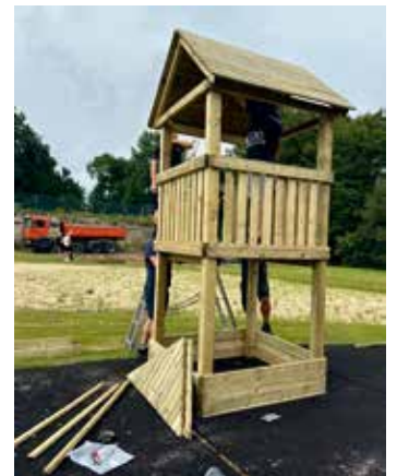
Aufbau unseres neuen Spielplatzes am Vereinsgelände
